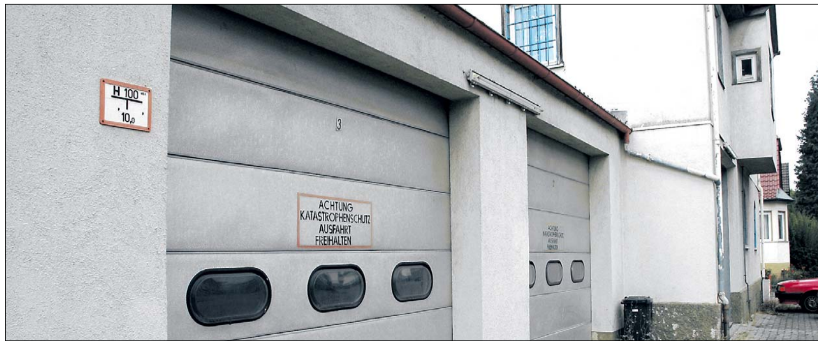
Vor etwa einem halben Jahr ist der Balingen Ortsverband des Technischen Hilfswerks auf das Gelände des früheren Malerbetriebs Stegmaier in Weilstetten umgezogen (oberes Bild). Derzeit sind die Renovierungsarbeiten in vollem Gang, auch muss das Dach der Garagen noch angehoben werden, um den teilweise hohen Fahrzeugen Platz zu bieten. Im früheren THW-Gebäude in der Tübinger Straße in Balingen sind nach wie vor die Zeichen der Vergangenheit zu erkennen (unteres Bild). Fotos: Klaus Irion
