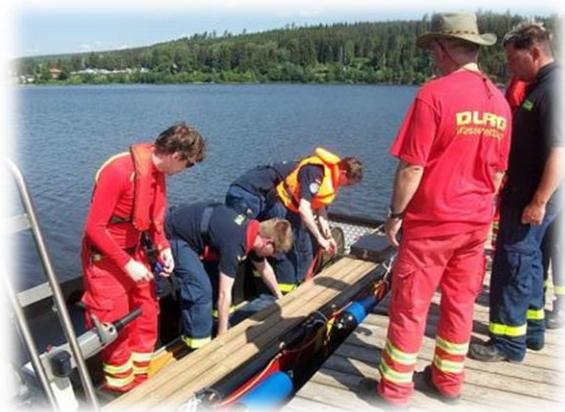
Mit Unterstützung des DLRG Bootes war das Verlegen ein "Kinderspiel". Schneller als angedacht war die Kabeltrommel Feldfernkabel (400 m Länge) auf dem Boot fixiert. Vom Boot aus wurde nun das Kabel zu Wasser gelassen und mit Gewichten beschwert, damit Schwimmer oder gar Boote nicht am Kabel hängen
